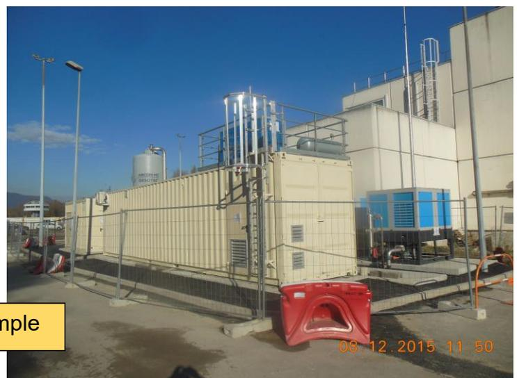
Les 3 premiers équipements sont placés en extérieur alors que l'ensemble de séparation membranaire est logé dans un container type maritime, ventilé et équipé d'une détection de gaz.
